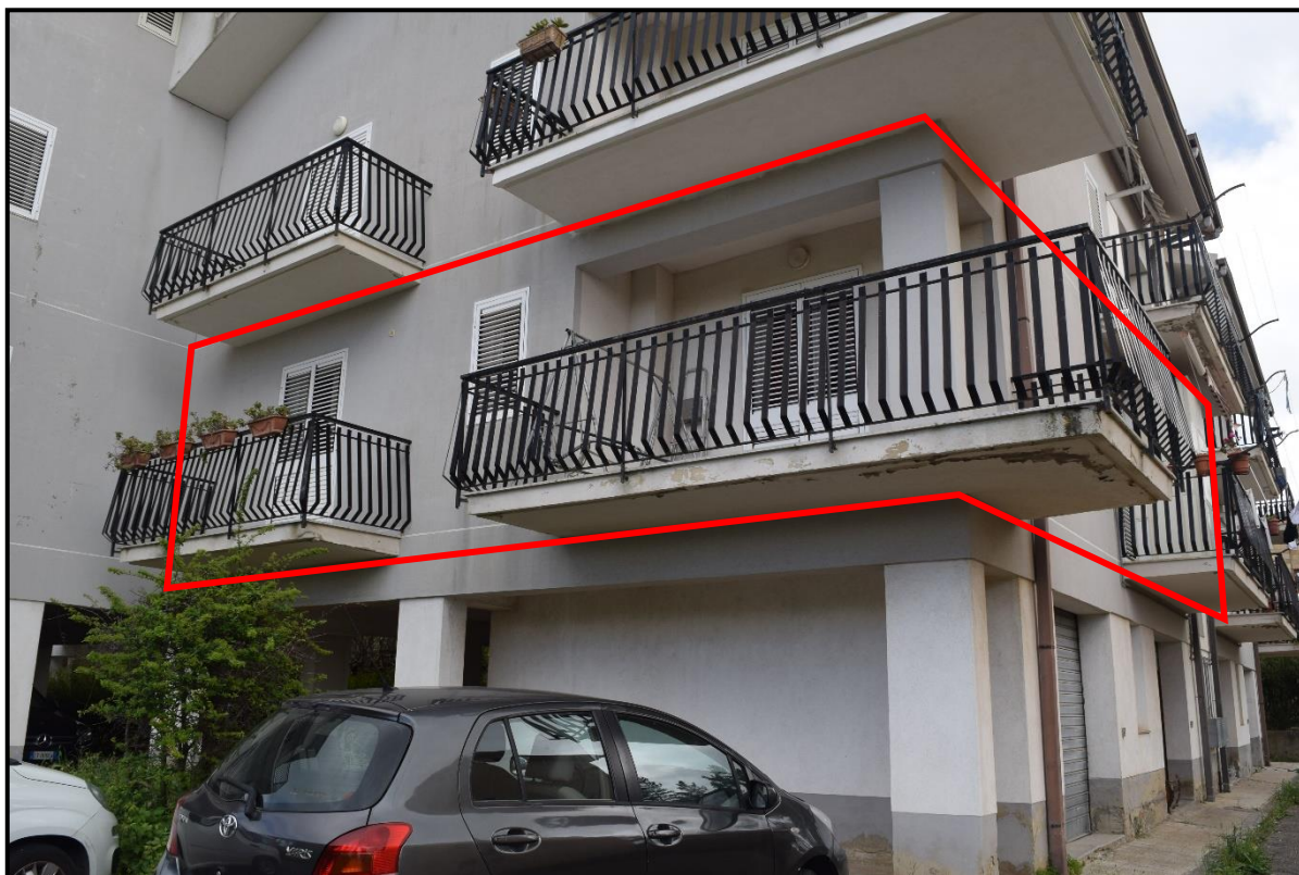
LOTTO 001 - FOTO 3 – NICOSIA - Foglio 83 - Particela 1260 - Sub. 3 - Vista del prospetto Sud - Ovest
