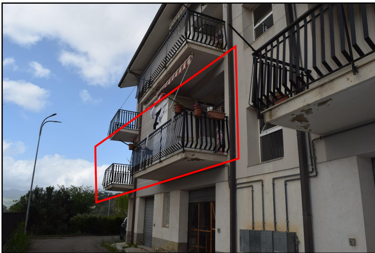
LOTTO 001 - FOTO 4 – NICOSIA - Foglio 83 - Particela 1260 - Sub. 3 - Vista del prospetto Sud
