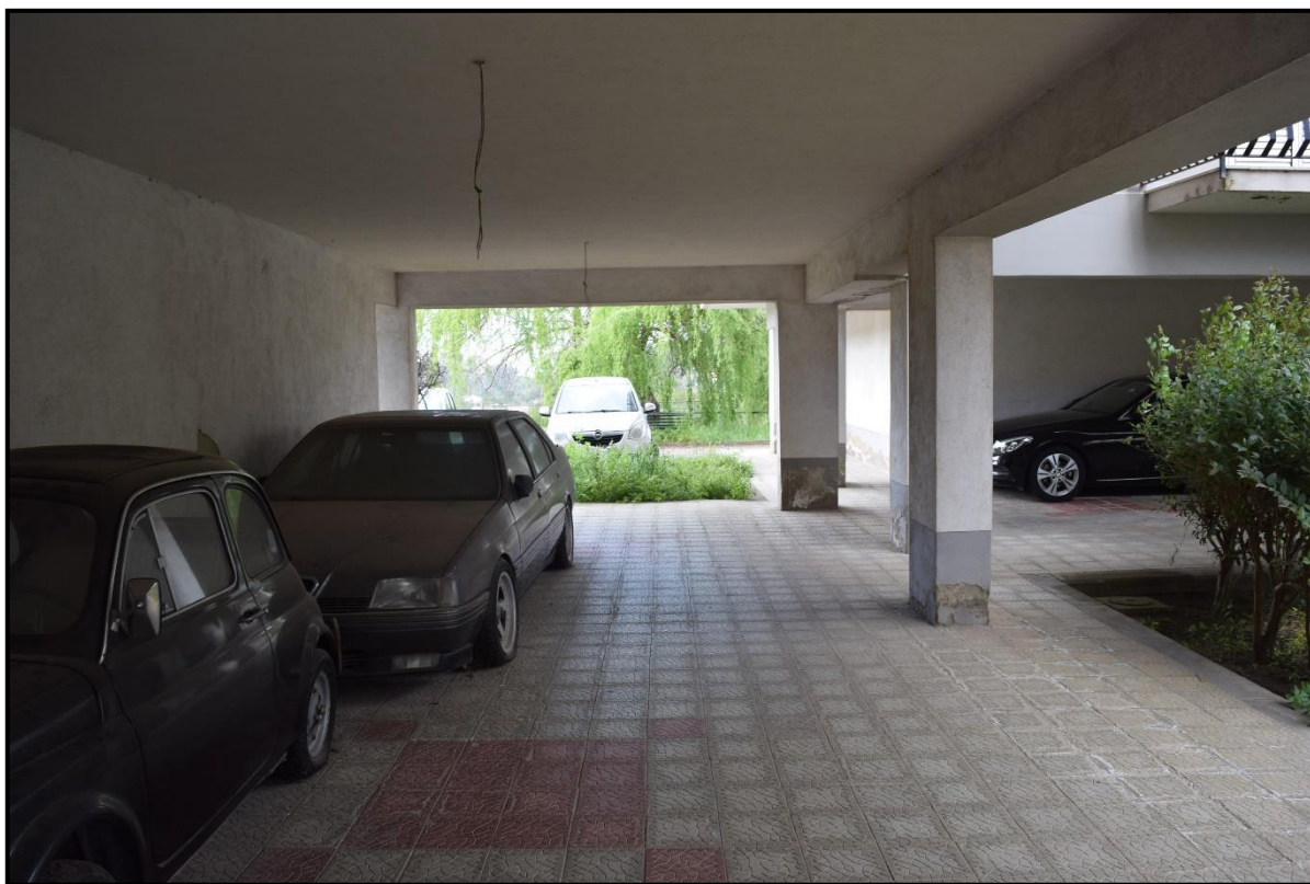
LOTTO 001- Corpo A - FOTO 6 – NICOSIA - Foglio 83 - Particela 1260 - Sub. 3 – Portico di accesso alla palazzina B
