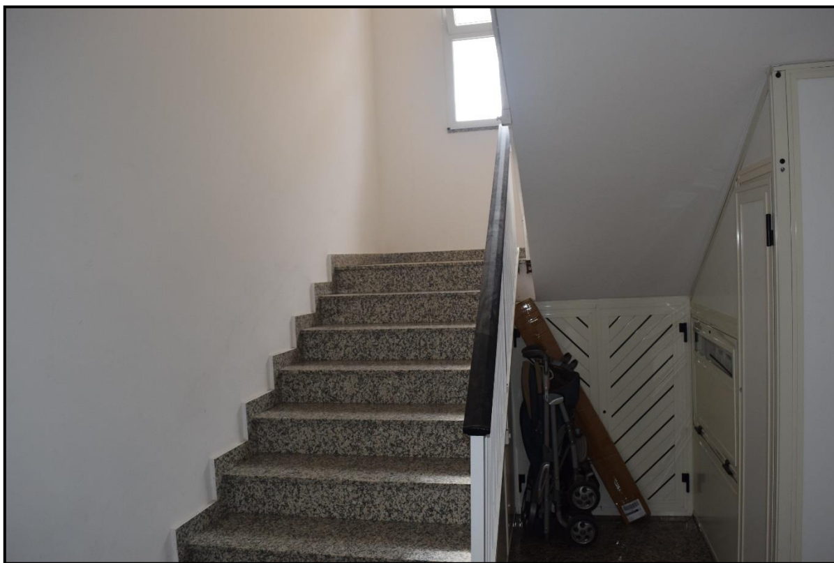
LOTTO 001- Corpo A - FOTO 8 – NICOSIA - Foglio 83 - Particela 1260 - Sub. 3 – Vano scala comune della palazzina B
