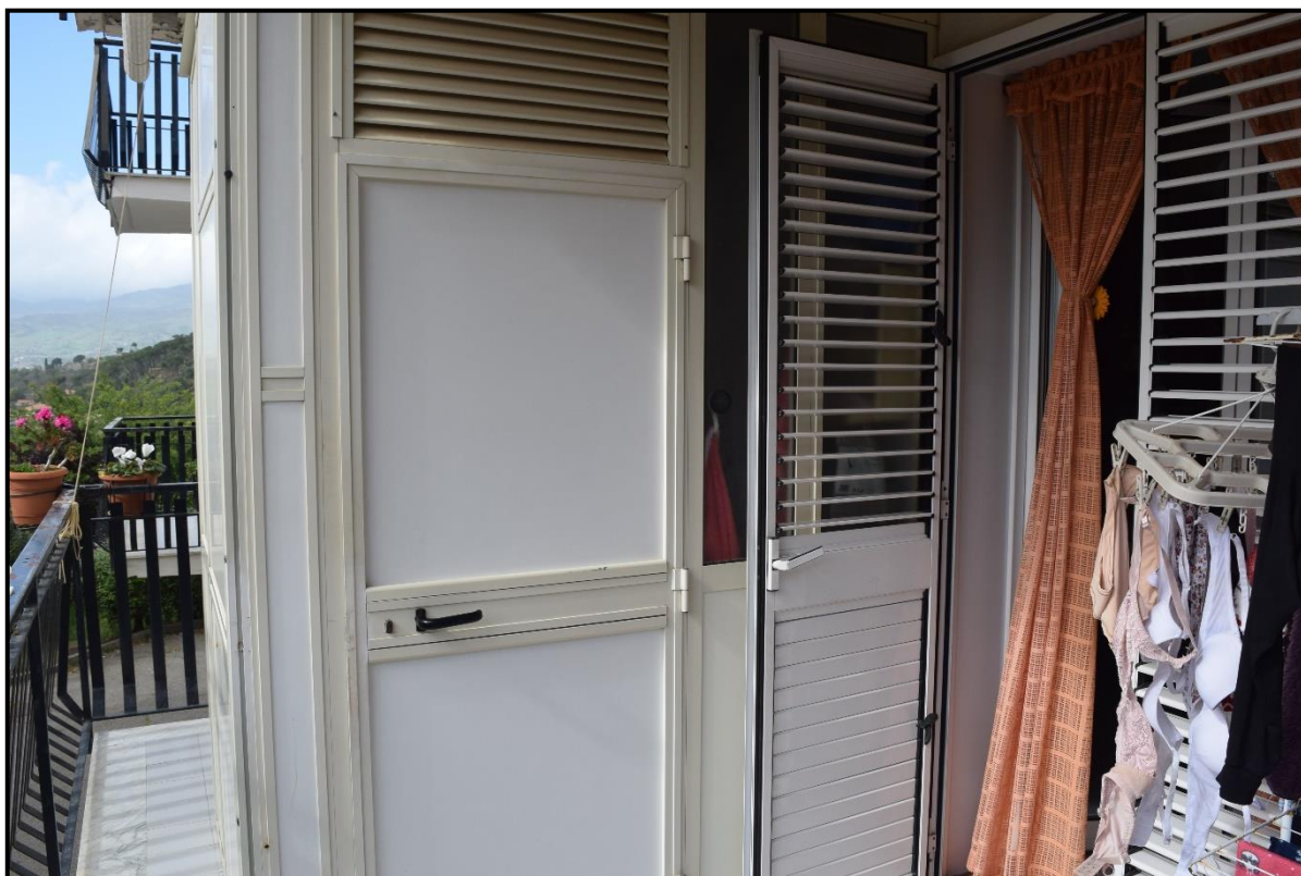
LOTTO 001- Corpo B - FOTO 25 – NICOSIA - Foglio 83 - Particela 1260 - Sub. 3 – Ballatoio vano cucina
