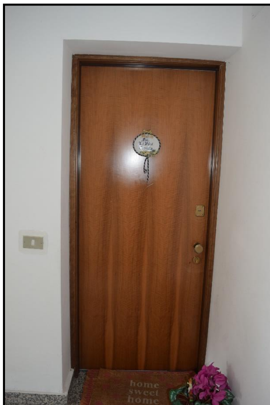
LOTTO 001- Corpo A - FOTO 9 – NICOSIA - Foglio 83 - Particela 1260 - Sub. 3 – Porta di accesso all'appartamento
