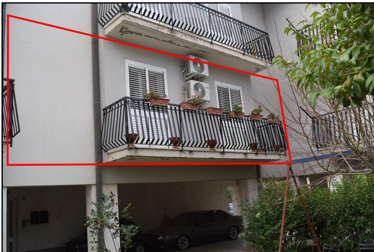
LOTTO 001- Corpo A - FOTO 5 – NICOSIA - Foglio 83 - Particela 1260 - Sub. 3 - Vista del prospetto Est
