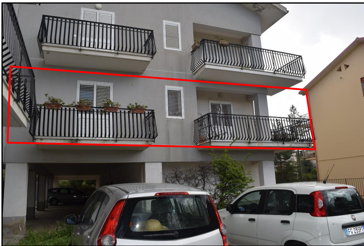
LOTTO 001 - FOTO 2 – NICOSIA - Foglio 83 - Particela 1260 - Sub. 3 - Vista del prospetto Ovest
